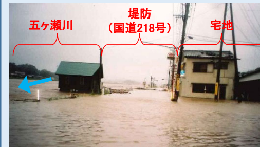
平成17年9月 台風14号 被災状況
