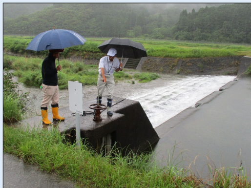
南浦土地改良区(延岡市)
